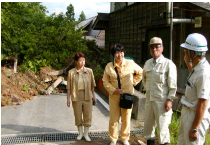
金山町の災害現場。民家に土砂が達しています（7月15日）
